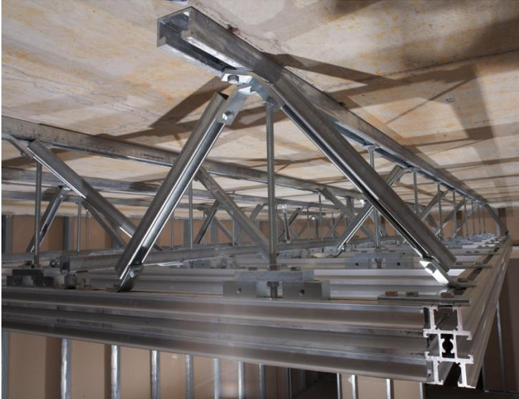
MSR Lastfelder sind vorgefertigte Schwerlastdeckenkonstruktionen, die für das jeweilige Röntgengerät entwickelt wurden und dem tatsächlichen Bedarf durch Konfigurationen angepasst werden.
